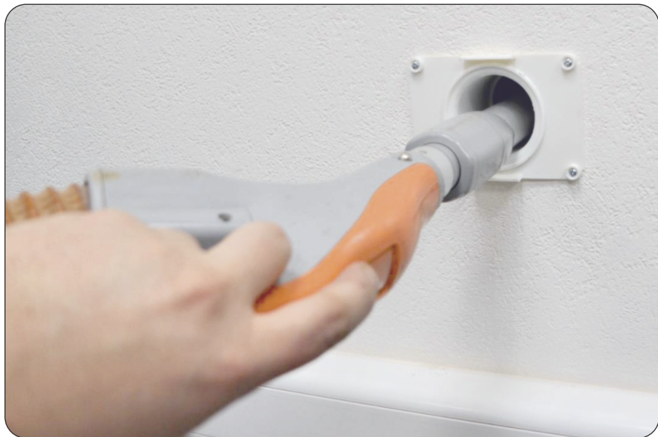
Рис. 8. Очистка воздухопроводящего канала бытовым пылесосом
